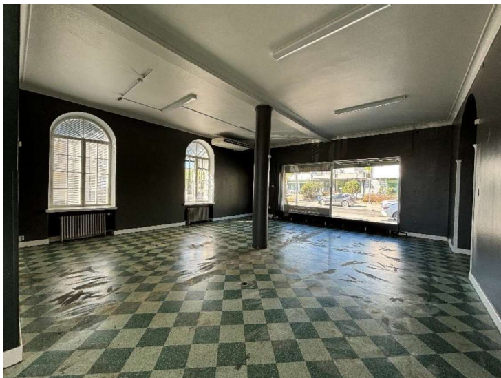
Pankkisaliksi aikanaan rakennettu tila ennen remonttia. Etualalle rakennetaan immersiotila ja taustalle lämpiö.
